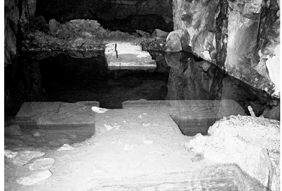
Abb. 23: Querstollen für die Kompressoranlage. Die Fundamente der Anlage in der 2 m tiefen Grube.
