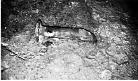
Abb. 22: Stollen 4 – in die Sohle verlegte Rohrleitung für Druckluft im Bereich des Mittelstollens. Der Stollen steht unter Wasser.
