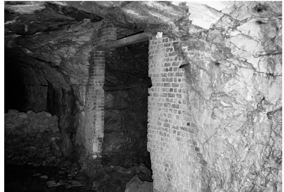
Abb. 24: Stollen 5 – ummauerter Eingang zum Querstollen für die Kompressoranlage.
