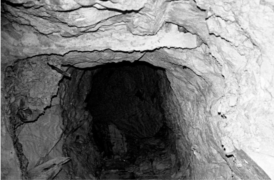
Abb. 18: Stollen 5, Aufbruch 2 mit einem quadratischen Querschnitt von ca.  $2 \times 2$  m<sup>2</sup>.
